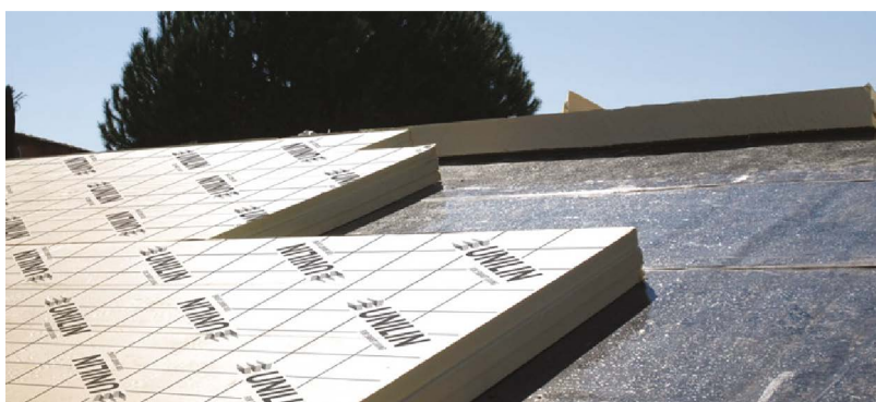
Przykładowa realizacja z wykorzystaniem izolacji Sarking LE
